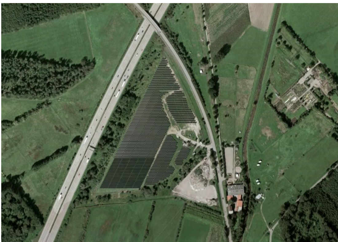
Rys 11) Elektrownia fotowoltaiczna w Iffezheim (źródło: Google maps).
