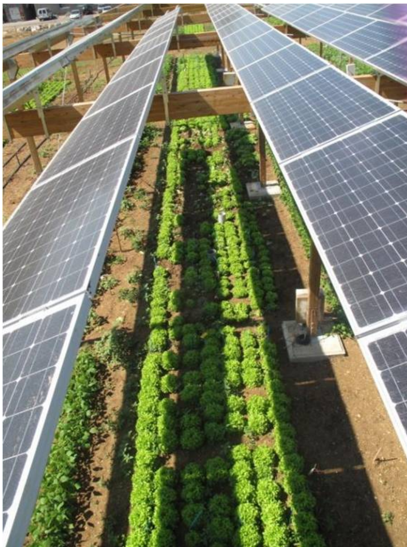
Rys 13) Przykład zainstalowanej elektrowni fotowoltaicznej na gruncie, który jest nadal użytkowany rolniczo.
