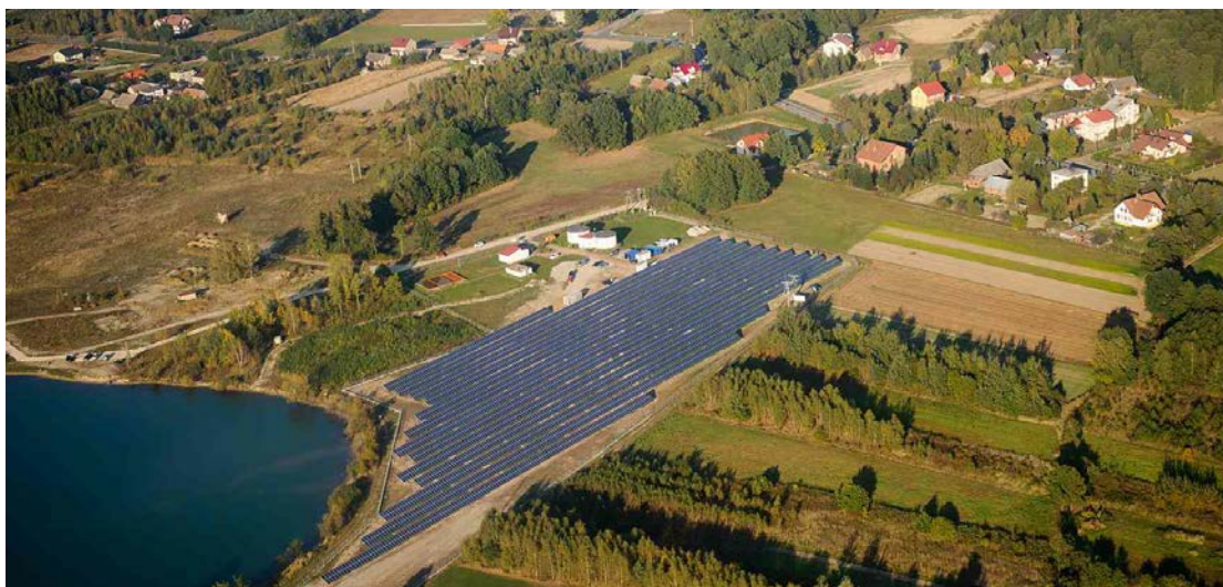
Rys 12) Elektrownia fotowoltaiczna w Wierchosławicach (źródło: http://www.forumfree.pl 05.12.2012)
