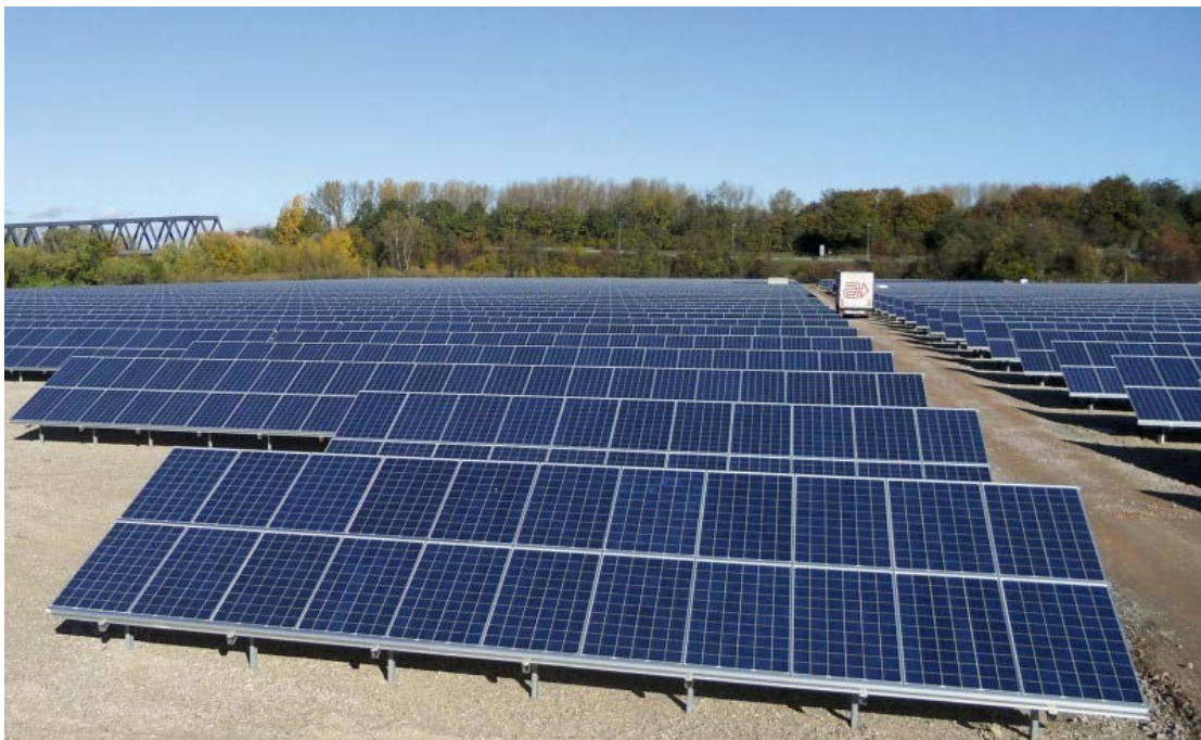
Rys 10) Elektrownia fotowoltaiczna w Iffezheim (źródło: http://www.wuerth-solar.de/solar/de/wuerth_solar_2012/unternehmen_1/referenzen_4/referenzen_12/referenzen.php 05.11.2012)
