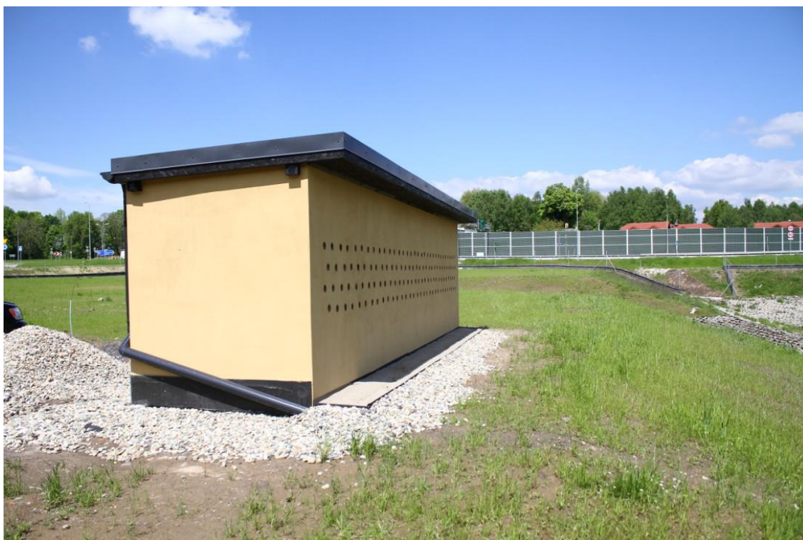
Fot. 13. Ukończony obiekt przy Autostradzie A1 (14.05.2013 r.)
