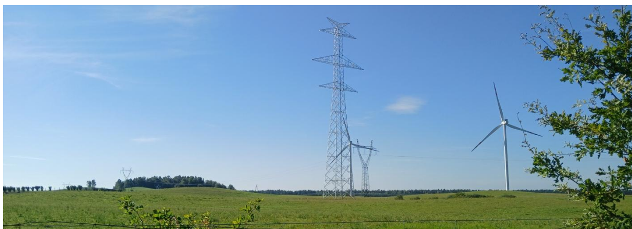
Fot. 11. Widok ku południowemu zachodowi z drogi Świerszczewo-Stepień na teren położony w otoczeniu obszaru projektu „Planu...” w obrębie Stepień: istniejąca linia WN 220 kV, słup budowanej linii NN 2x400 kV oraz elektrownie wiatrowe.
