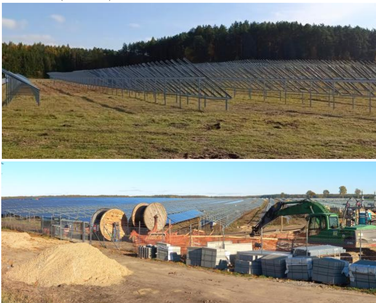
Fot. 12 i 13. Stalowe konstrukcje paneli fotowoltaicznych na etapie budowy
