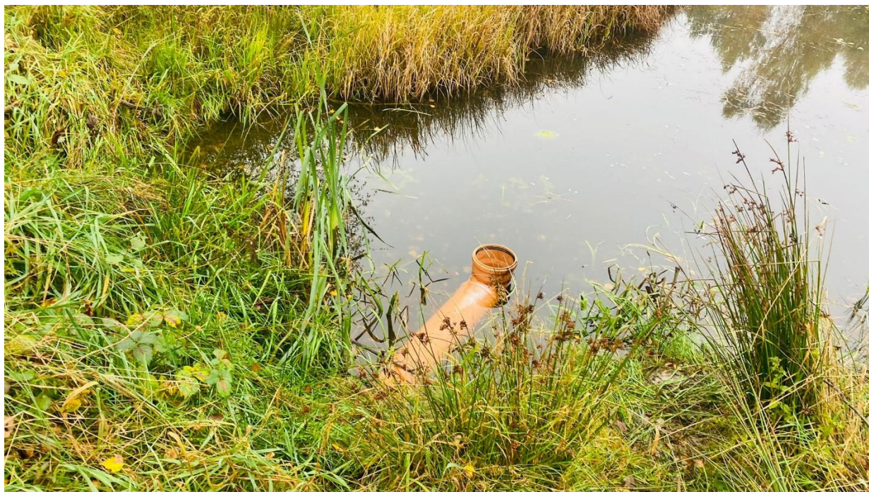
Zdjęcie 3. Istniejący przelew fi200 ze stawu nr 4 do stawu nr 3.
