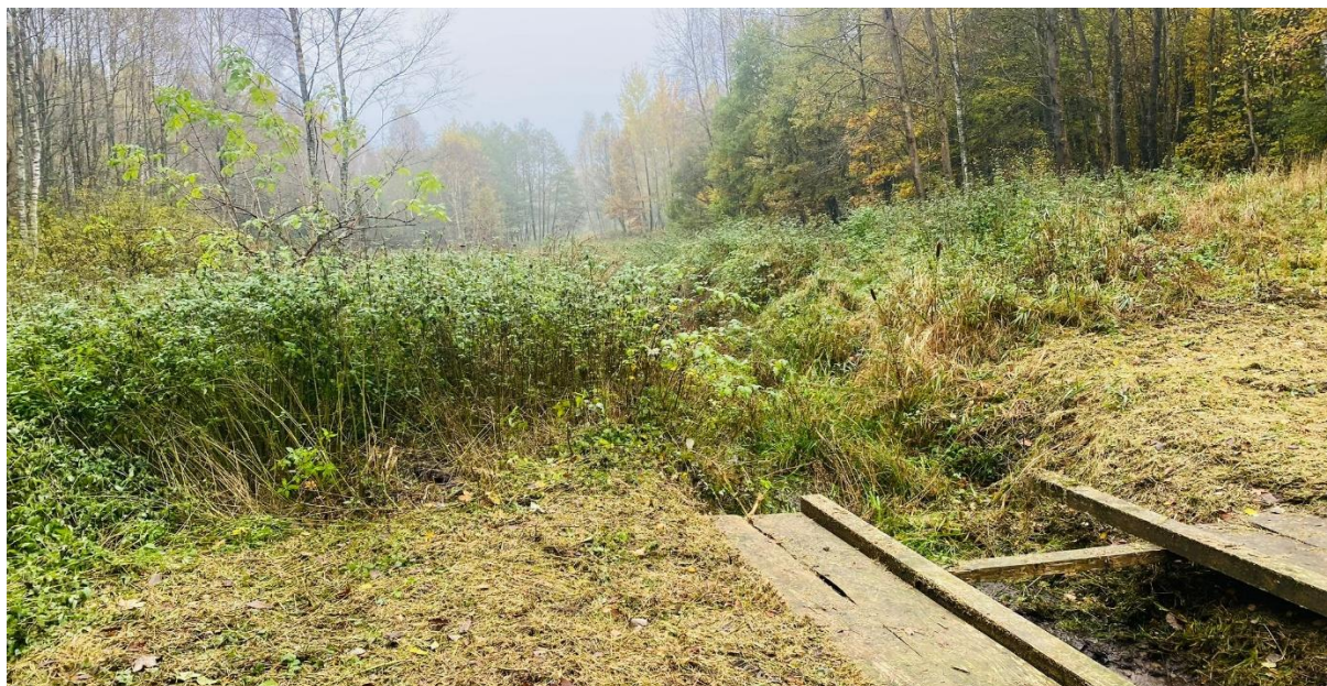
Zdjęcie 5. Odbiornik – rów na działce 58 i 60/3 obręb Kołtki.
