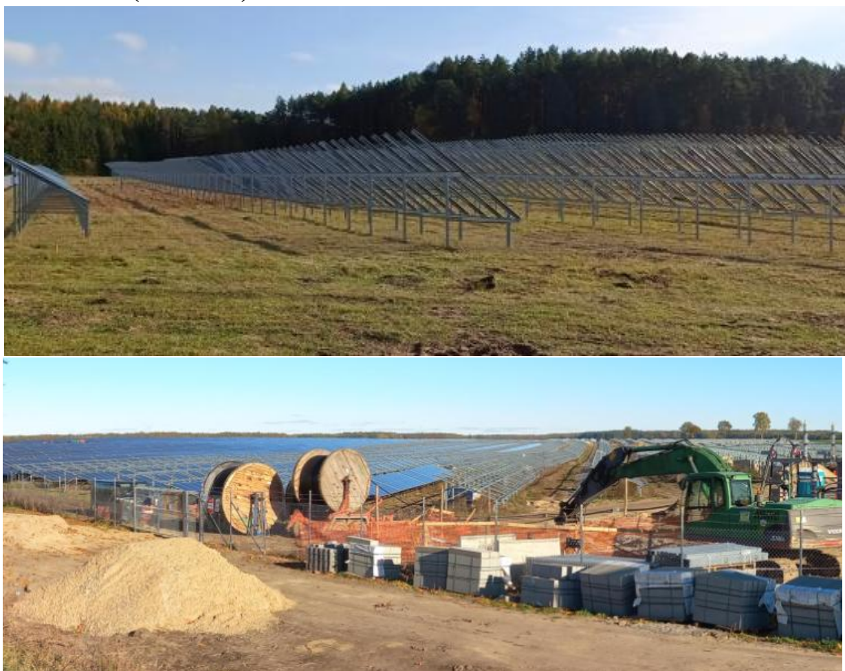
Fot. 12 i 13. Stalowe konstrukcje paneli fotowoltaicznych na etapie budowy
