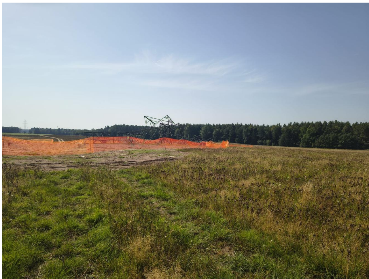
Zdjęcie 11 Konstrukcja budowy sieci 400 kV
