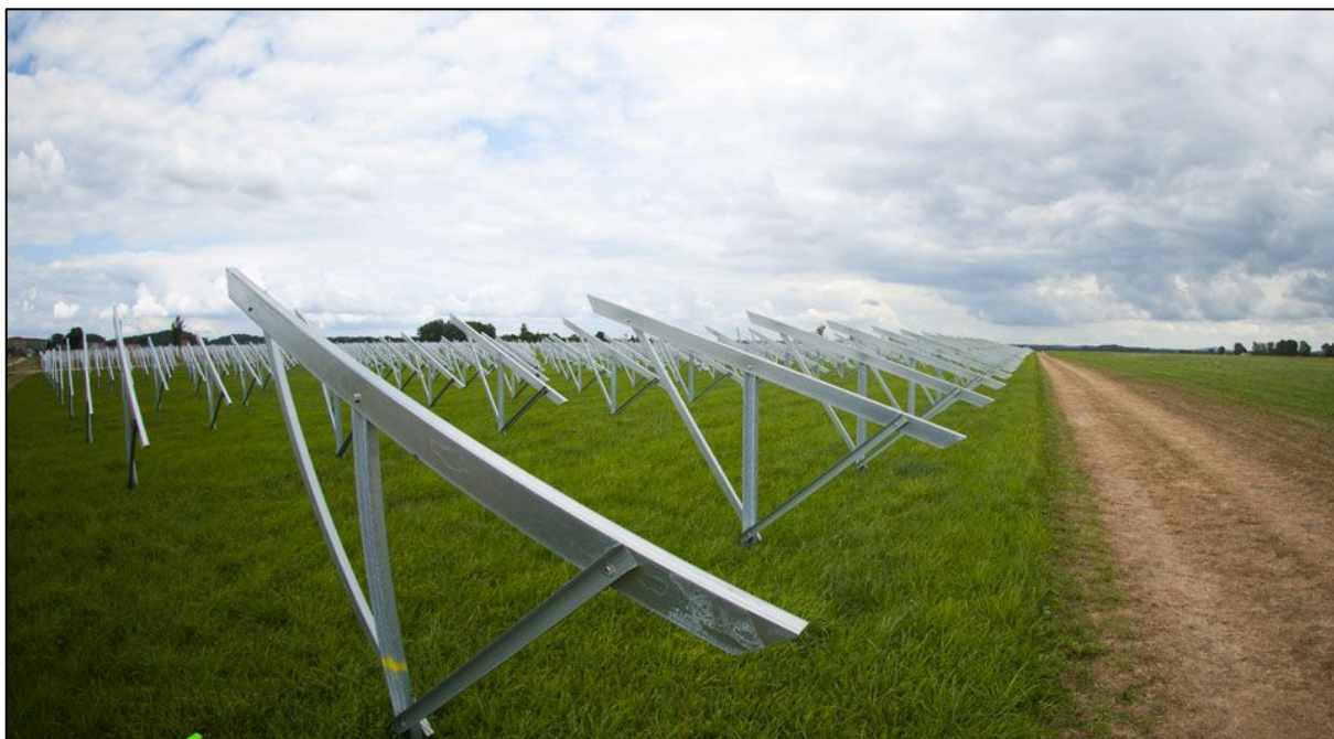
Rycina 47 Metalowe lub aluminiowe konstrukcje pod panele fotowoltaiczne
