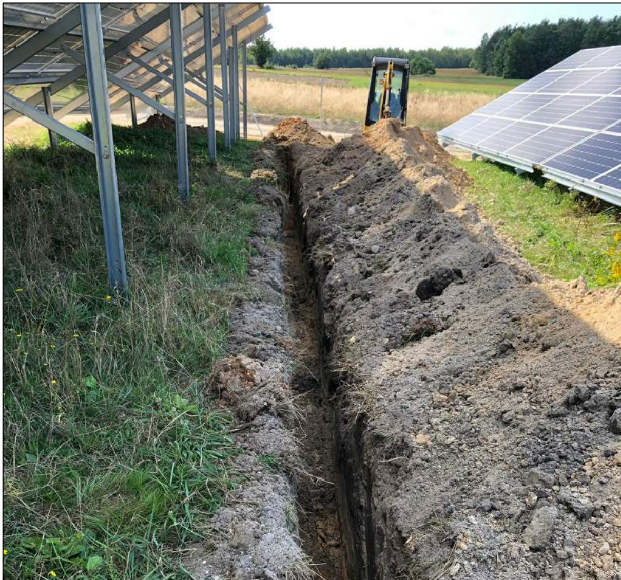
Rycina 49 Przykładowy wykop pod kable na terenie inwestycji (fot. materiały Inwestora)
