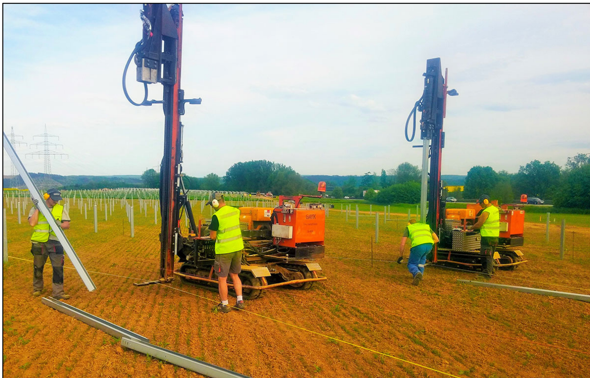
Rycina 48 Mocowanie profili za pomocą kufaru
