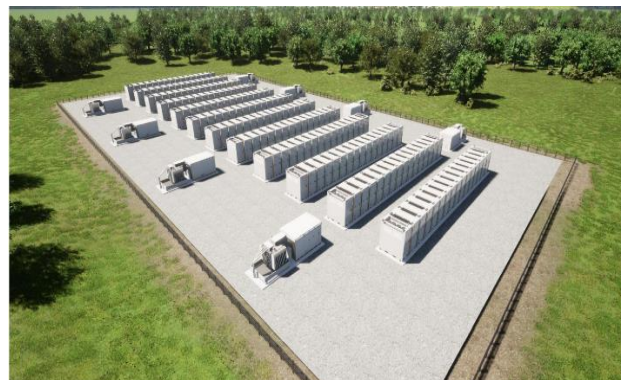
Fot. 5. Zespół modułowych magazynów energii
