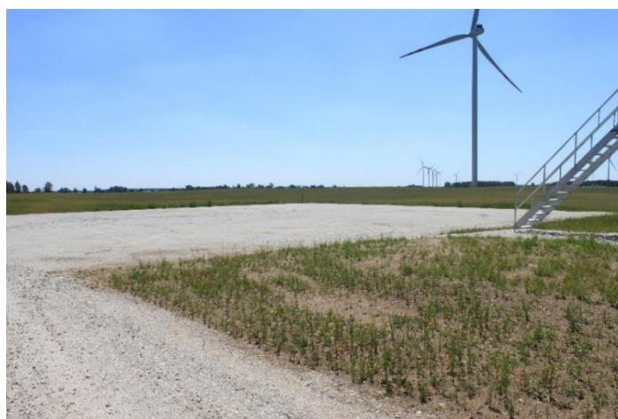
Fot. 32. Szutrowy plac manewrowy koło wieży elektrowni wiatrowej
