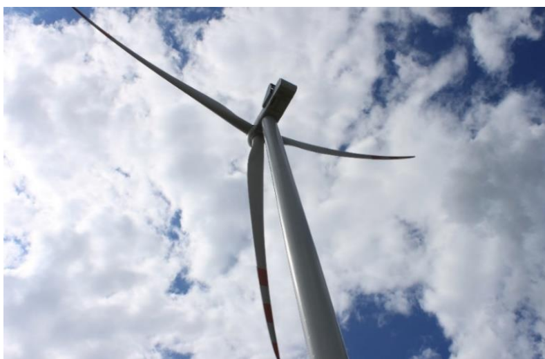
Fot. 27. Rotor elektrowni wiatrowej – źródło hałasu
