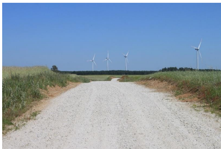
Fot. 31. Szutrowa droga dojazdowa do elektrowni wiatrowych
