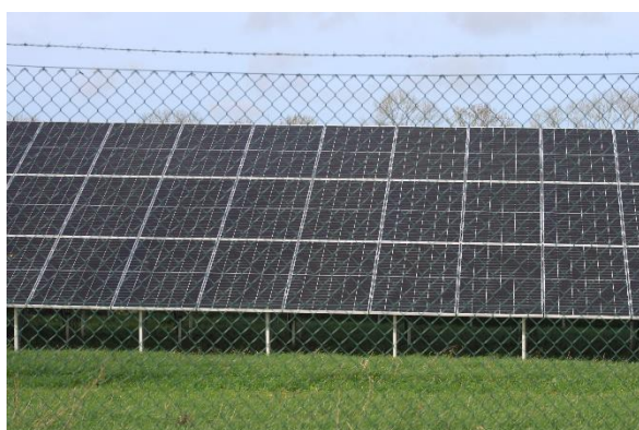
Fot. 33. Widok farmy fotowoltaicznej z bezpośredniego otoczenia
