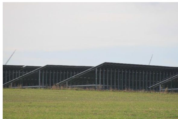
Fot. 34. Widok farmy fotowoltaicznej na terenie równinnym od tyłu
