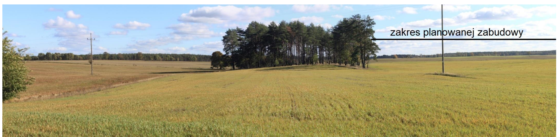
Fot. 16. Widok z północnego zachodu z lokalnej drogi gruntowej Biała-Białka w kierunku południowo-wschodnim (zabudowa widoczna w znikomym zakresie, z minimalnej odległości ok. 1,6 km, za pasem planowanej zieleni rekreacyjno-krajobrazowej)
