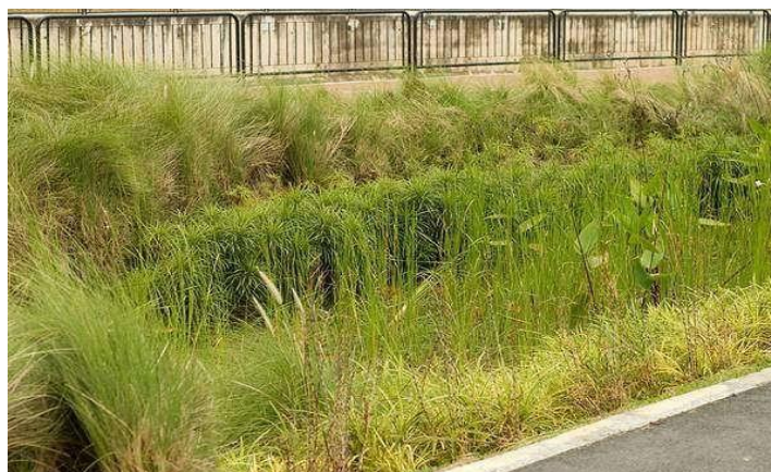
Fot. 8. Ogród deszczowy przy drodze (źródło: https://landarchs.comrain-gardens-essentialguide )
