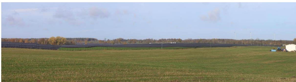
Fot. 3. Przykładowy widok dużej farmy fotowoltaicznej (Zwartowo w woj. pomorskim) z odległości ok. 300-500 m na terenie równinnym i lekko falistym – bez zastosowania pasów zieleni izolacyjno-krajobrazowej .
