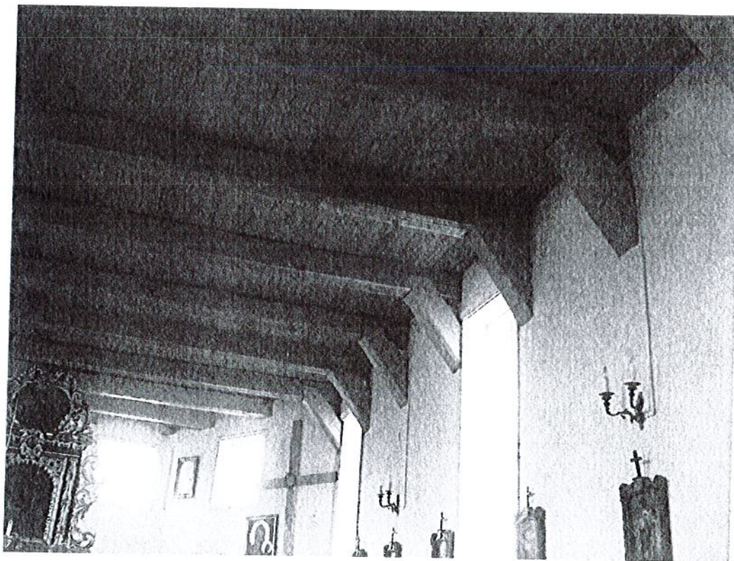
Fot.1 Strop belkowy
