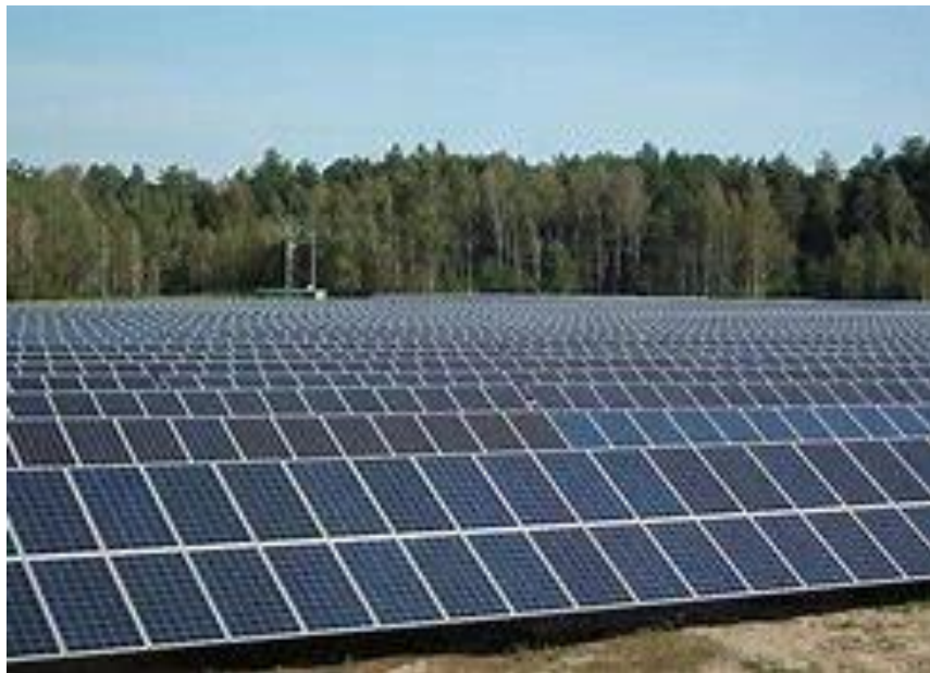
Fot. 8. Przykładowa farma fotowoltaiczna
