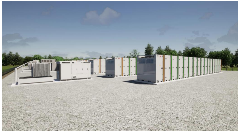
Rys. 5a. Przykład modułowego magazynu energii
