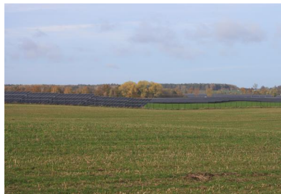
Fot. 24. Widok farmy fotowoltaicznej z odległości ok. 200 m na terenie lekko falistym
