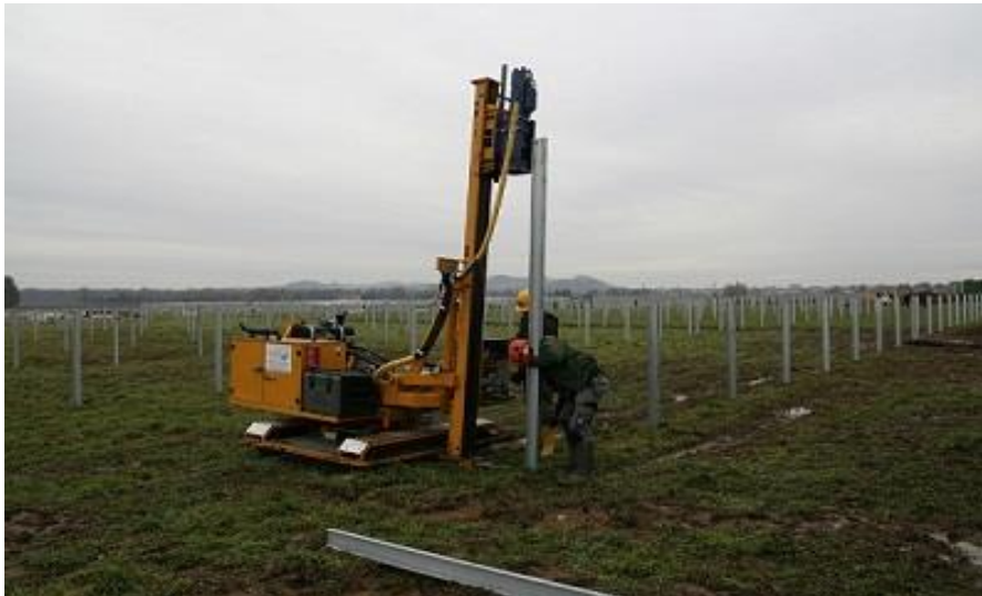
Fot. 5. Wbijanie w grunt podpór konstrukcji wsporczych ogniw ( http://gramwzielone.pl/ )
