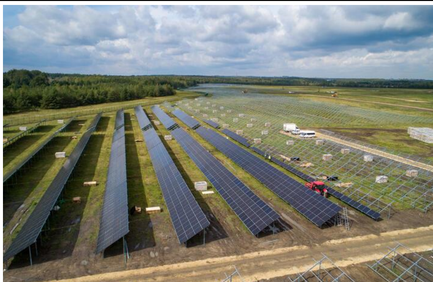
Fot. 7. Farma fotowoltaiczna w trakcie budowy ( https://msm.com.pl )
