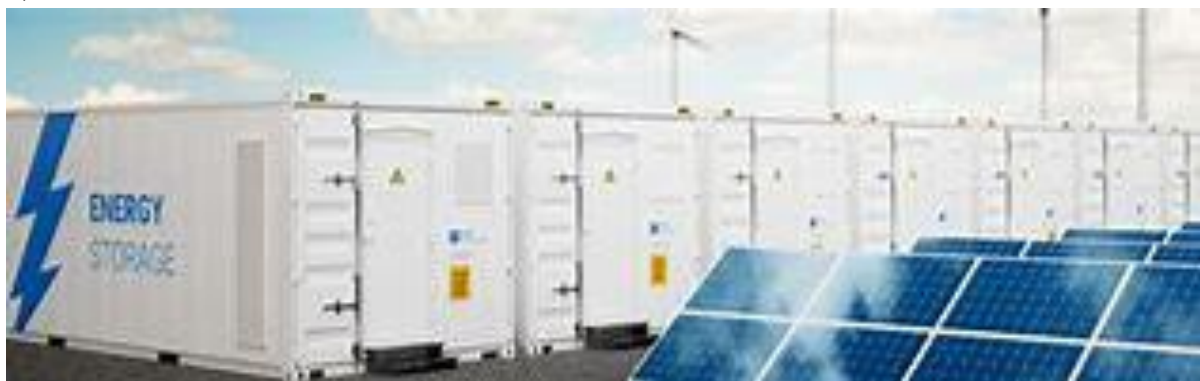
Rys. 3. Przykład kontenerowego magazynu energii (a) i wizualizacja grupy kontenerów (b)
