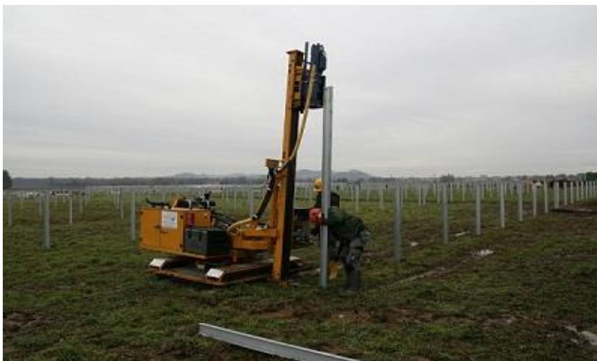
Fot. 11. Wbijanie w grunt podpór konstrukcji wsporczych ogniw fotowoltaicznych ( http://gramwzielone.pl/ )
