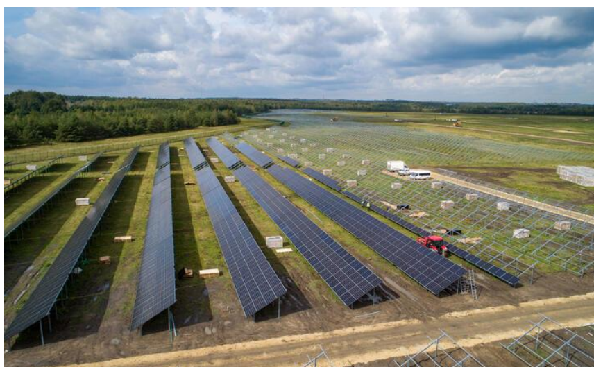
Fot. 13. Farma fotowoltaiczna w trakcie budowy ( https://msm.com.pl/ )
