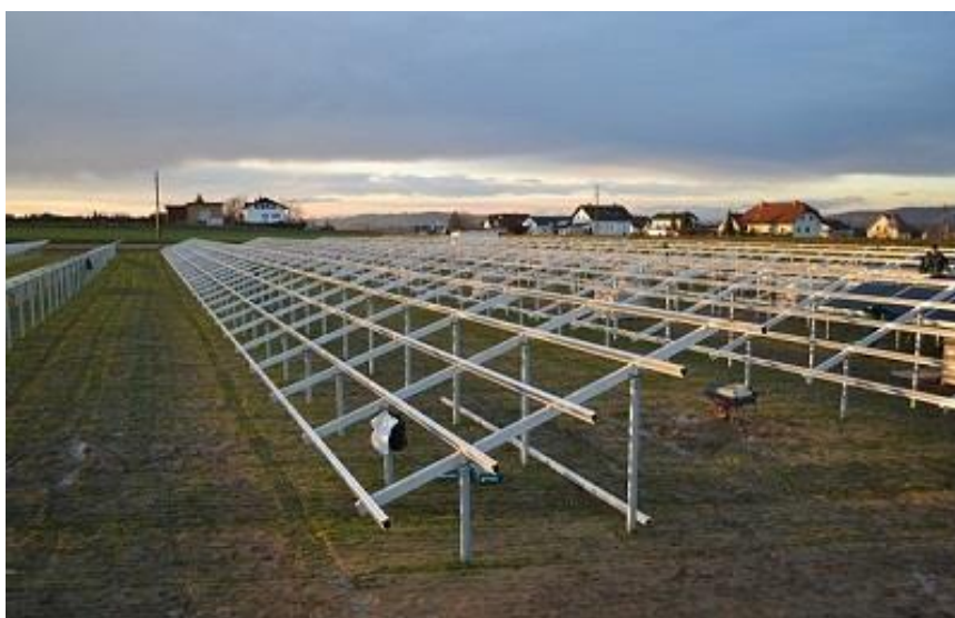
Fot. 12. Konstrukcje wsporcze ogniw fotowoltaicznych ( http://gramwzielone.pl/ )
