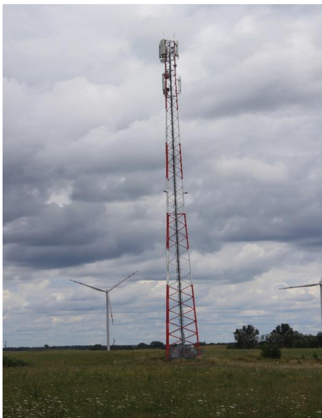
Fot. 30. Jedna z dwóch wież telefonii komórkowej w Świerszczewie
