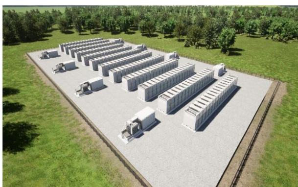
Fot. 5. Zespół modułowych magazynów energii
