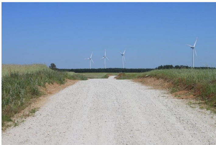
Fot. 31. Szutrowa droga dojazdowa do elektrowni wiatrowych
