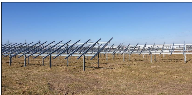
Pic. 8. Sposób montażu konstrukcji fotowoltaicznych.
