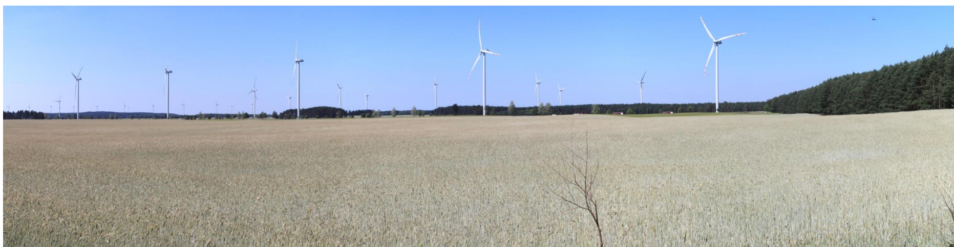
Fot. 14. Widok z północno-wschodniego krańca terenu w kierunku zachodnim, w głębi elektrownie wiatrowe Farmy Wiatrowej „Biały Bór”.
