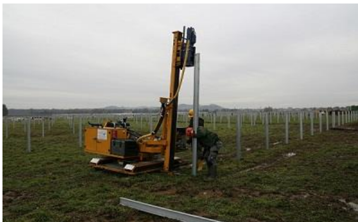
Fot. 3. Wbijanie podpór konstrukcji wsporczych mikro kafarem ( http://gramwzielone.pl/ )
