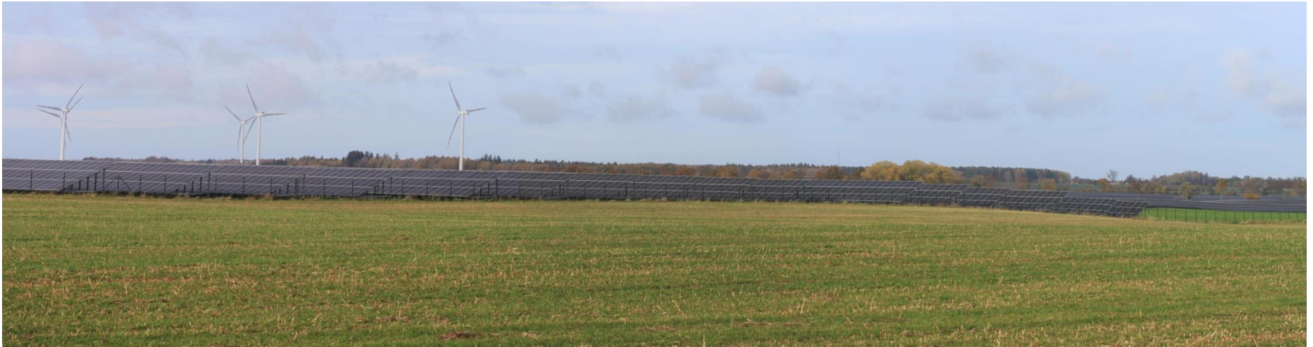
Fot. 27. Przykład jednoczesnej widoczności z odległości ok. 100-200 m farmy fotowoltaicznej i za nią farmy wiatrowej koło Zwartowa (gm. Choczewo w woj. pomorskim)
