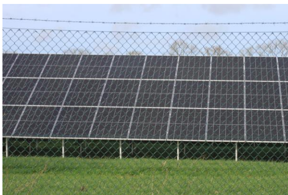
Fot. 15. Widok farmy fotowoltaicznej z bezpośredniego otoczenia
