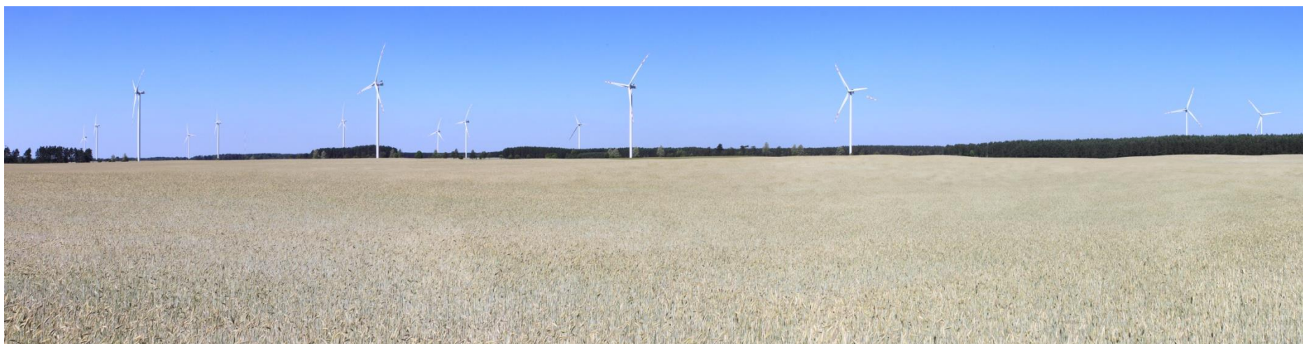
Fot. 12. Widok z drogi gruntowej w kierunku zachodnim, w głębi elektrownie Farmy Wiatrowej „Biały Bór”.
