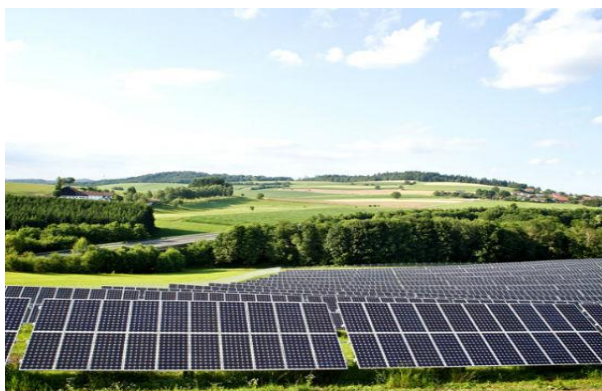
Fot. 2a. Przykład zespołu paneli fotowoltaicznych w układzie dwóch rzędów pionowych
