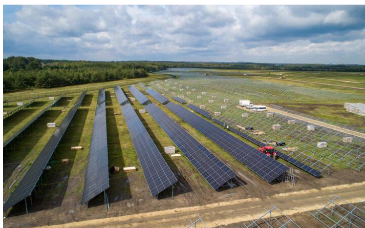
Fot. 5. Farma fotowoltaiczna w trakcie budowy ( https://msm.com.pl/ )
