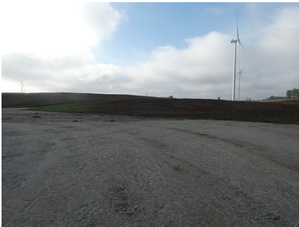
Fot. 21 Teren jednego z placów manewrowych pod turbiny wiatrowe; rejon dz. ewid. 184/22
