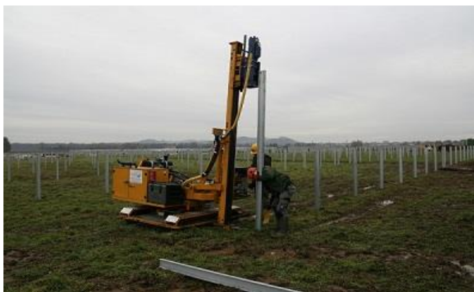
Fot. 11. Montaż konstrukcji wsporczych ogniw fotowoltaicznych ( http://gramwzielone.pl/ )
