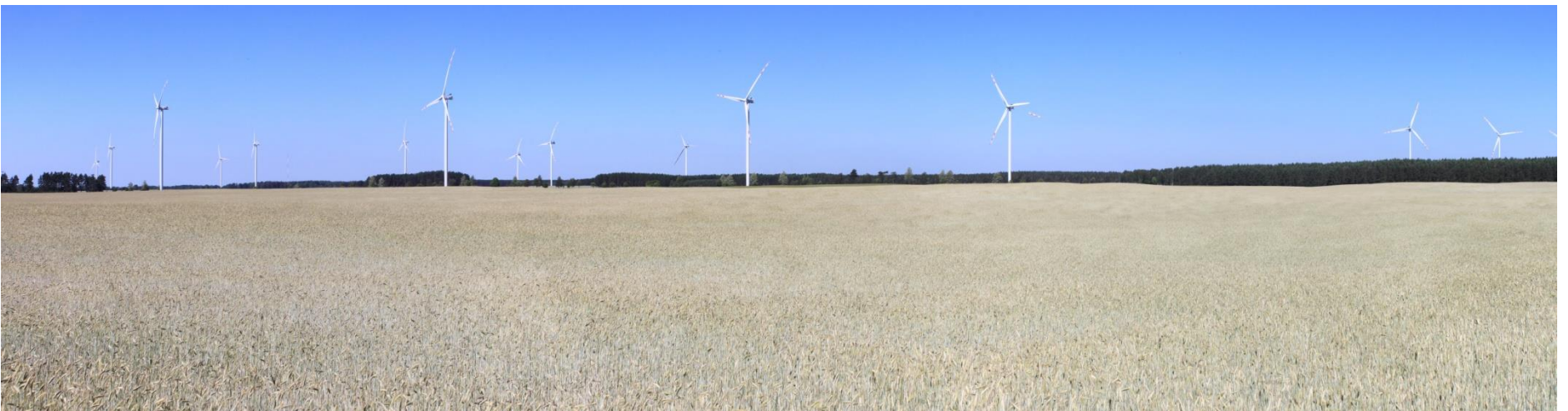
Fot. 8. Widok z drogi gruntowej w kierunku zachodnim, w głębi elektrownie Farmy Wiatrowej „Biały Bór”.
