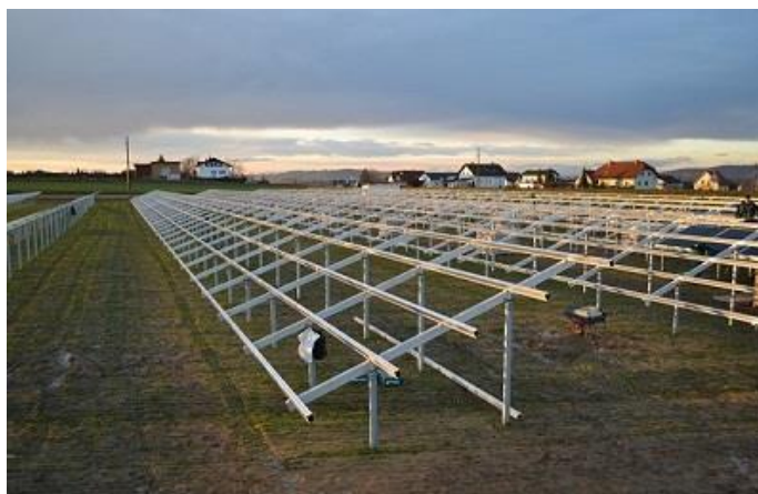
Fot. 12. Konstrukcje wsporcze ogniw fotowoltaicznych ( http://gramwzielone.pl/ )
