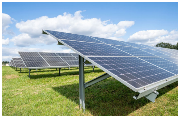
Rys. 3.5. Przedstawienie przykładowych konstrukcji pod panele fotowoltaiczne
