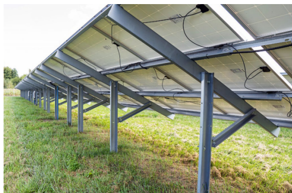
Rys. 3.5. Przedstawienie przykładowych konstrukcji pod panele fotowoltaiczne
