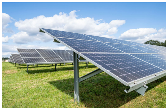
Rys. 3.5. Przedstawienie przykładowych konstrukcji pod panele fotowoltaiczne
