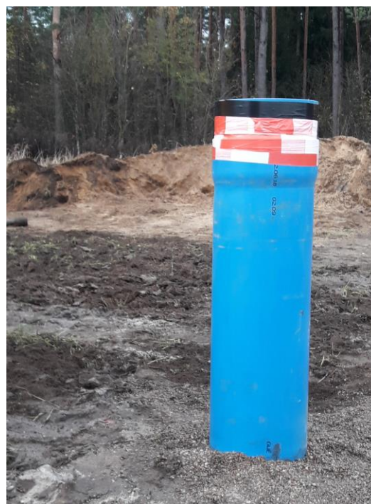
Zabezpieczenie otworu wiertniczego S-2
