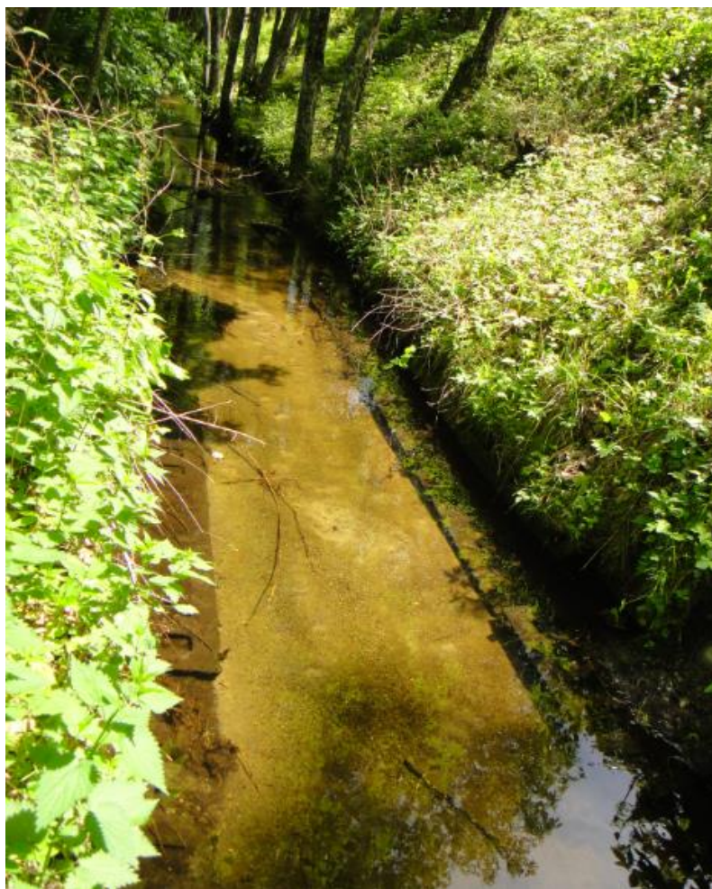
Ryc. 4.22. Ciek wodny – widoczne strome skarpy i elementy umocnień.
