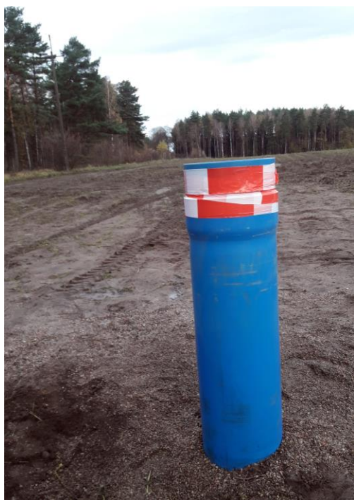
Zabezpieczenie otworu wiertniczego S-1
