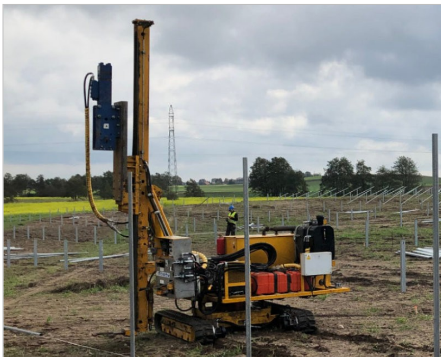
Rysunek 24. Wbijanie słupów nośnych pod konstrukcję modułów PV.
