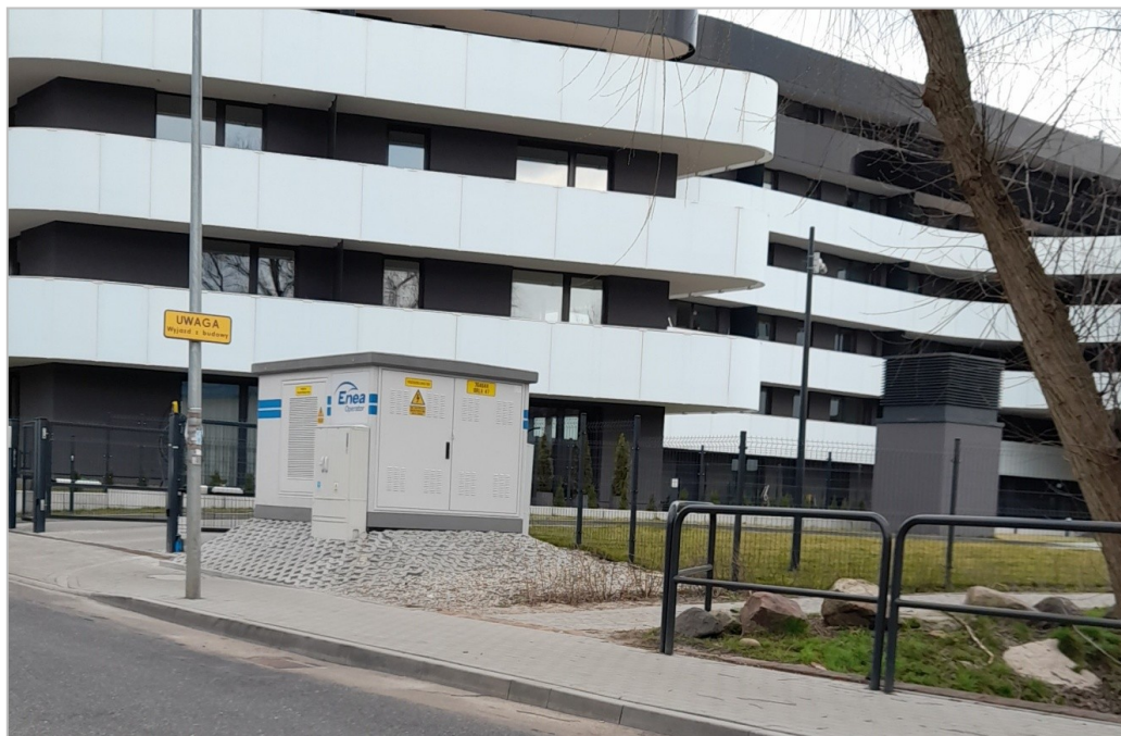
Rysunek 26. Lokalizacja stacji transformatorowej wśród zabudowy mieszkaniowej wielorodzinnej
