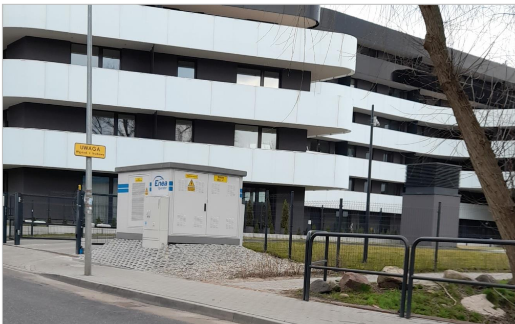
Rysunek 32. Lokalizacja stacji transformatorowej wśród zabudowy mieszkaniowej wielorodzinnej
