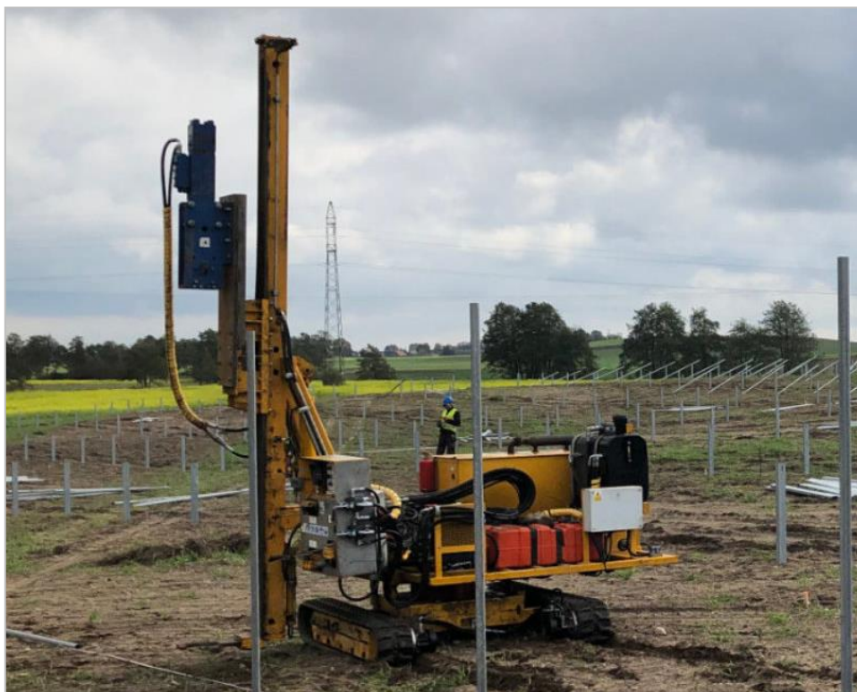
Rysunek 31. Wbijanie słupów nośnych pod konstrukcję modułów PV.
