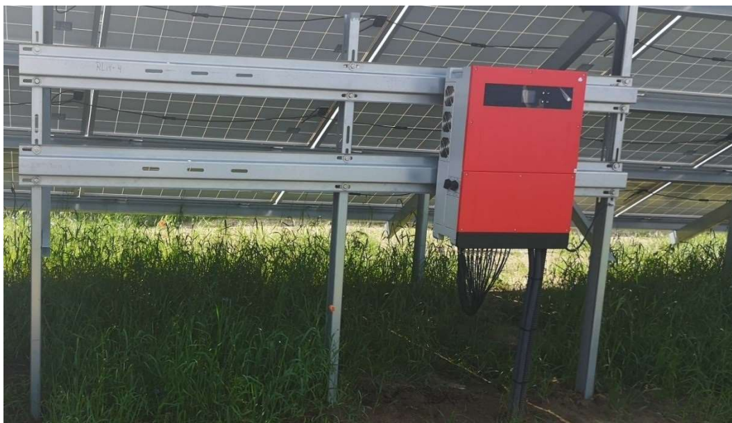
Przykładowy falownik /inwerter i rozwiązanie montażu
