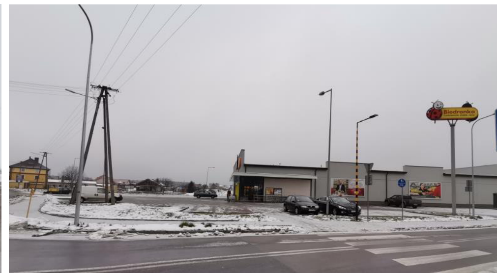
AMP8 – Parking przy sklepie Biedronka w miejscowości Czarne
