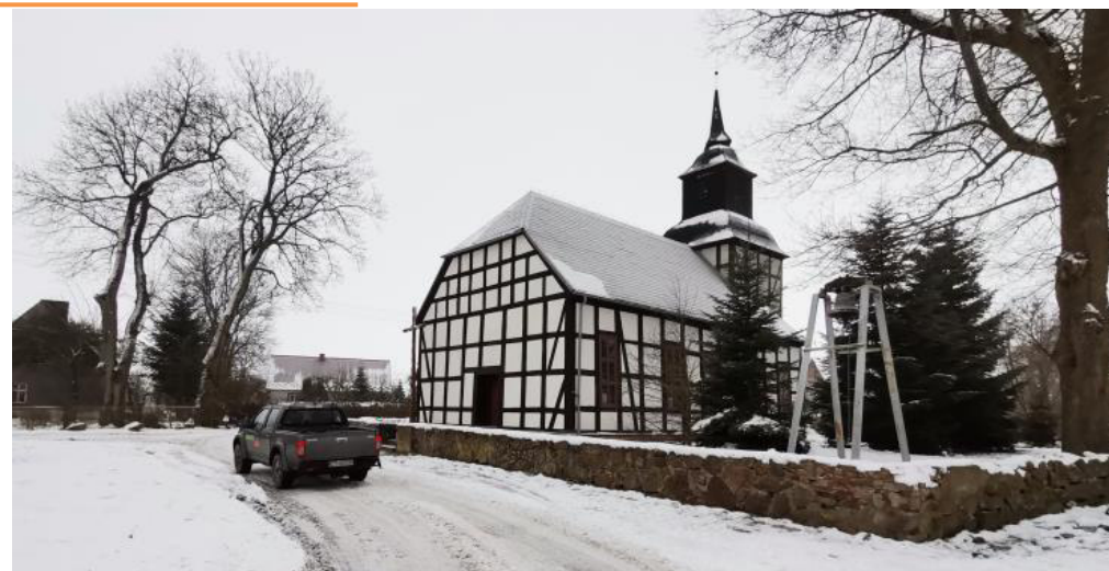
AMP-6 Kościół w miejscowości Węgorzewo
