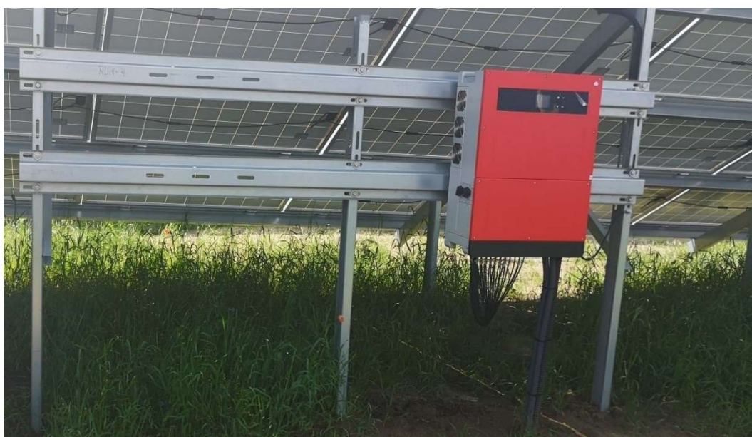
Przykładowy falownik /inwerter i rozwiązanie montażu
