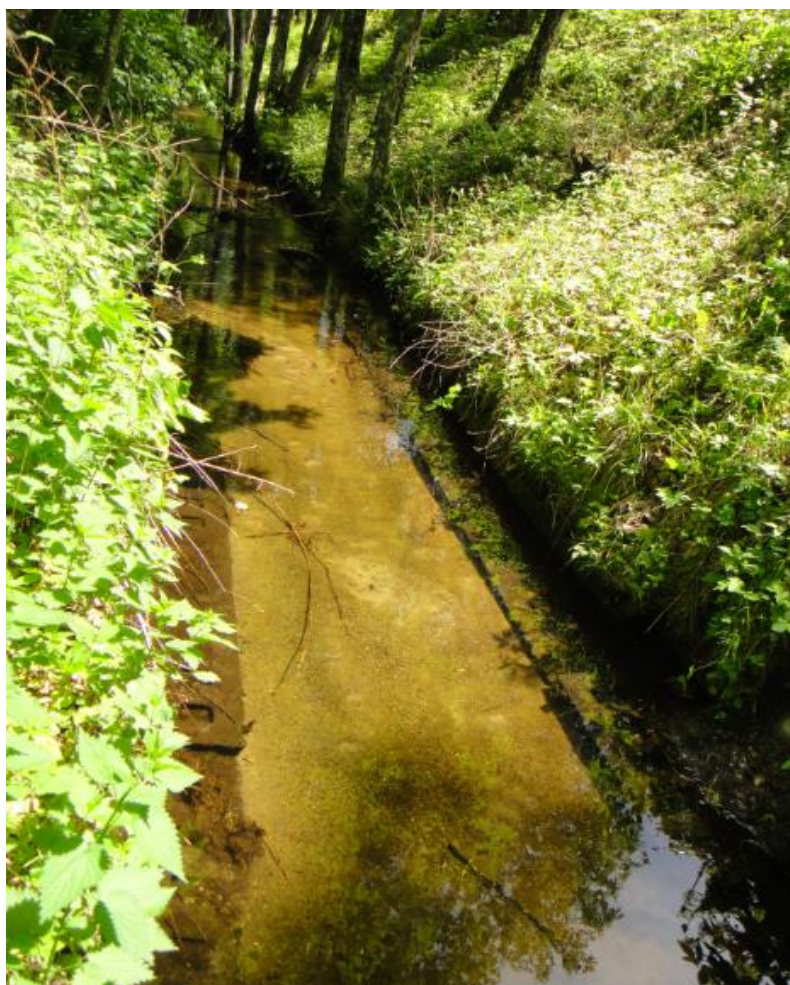
Ryc. nr 4.22. Ciek wodny – widoczne strome skarpy i elementy umocnień.
