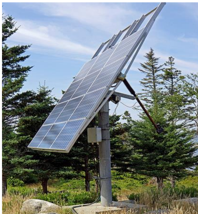
Rys. Solar tracker - budowa (źródło zdjęcia flickr.com, autor Dennis Jarvis)
